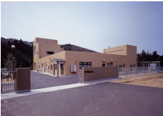
【最終処分場 浸出水処理施設】
