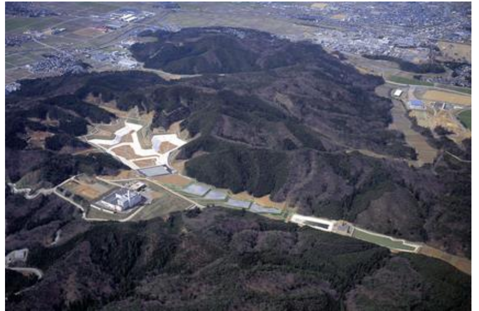
【一般廃棄物最終処分場】
